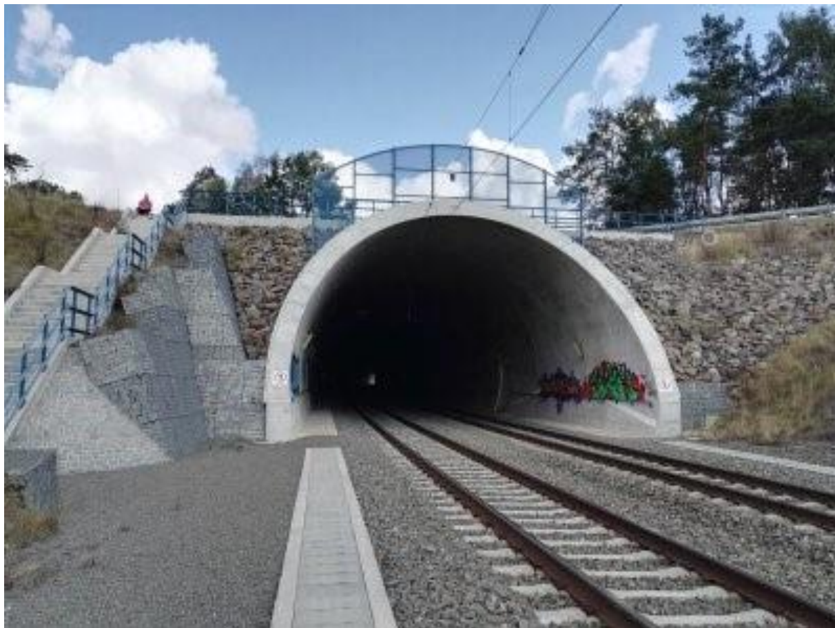
Obrázek č. 4 Rekonstruovaný Sudoměřický tunel na trati č. 220
